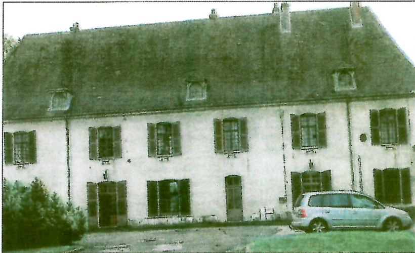
« Quinze appartements sont aménagés dans le château à Saint-Ylie. Ils sont vendus en lots bruts ou rénovés. Photo Nathalie BERTHEUX »
